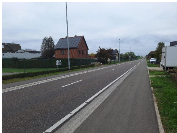
Foto 4: 2 resterende woningen ter hoogte van Blanklaarstraat
