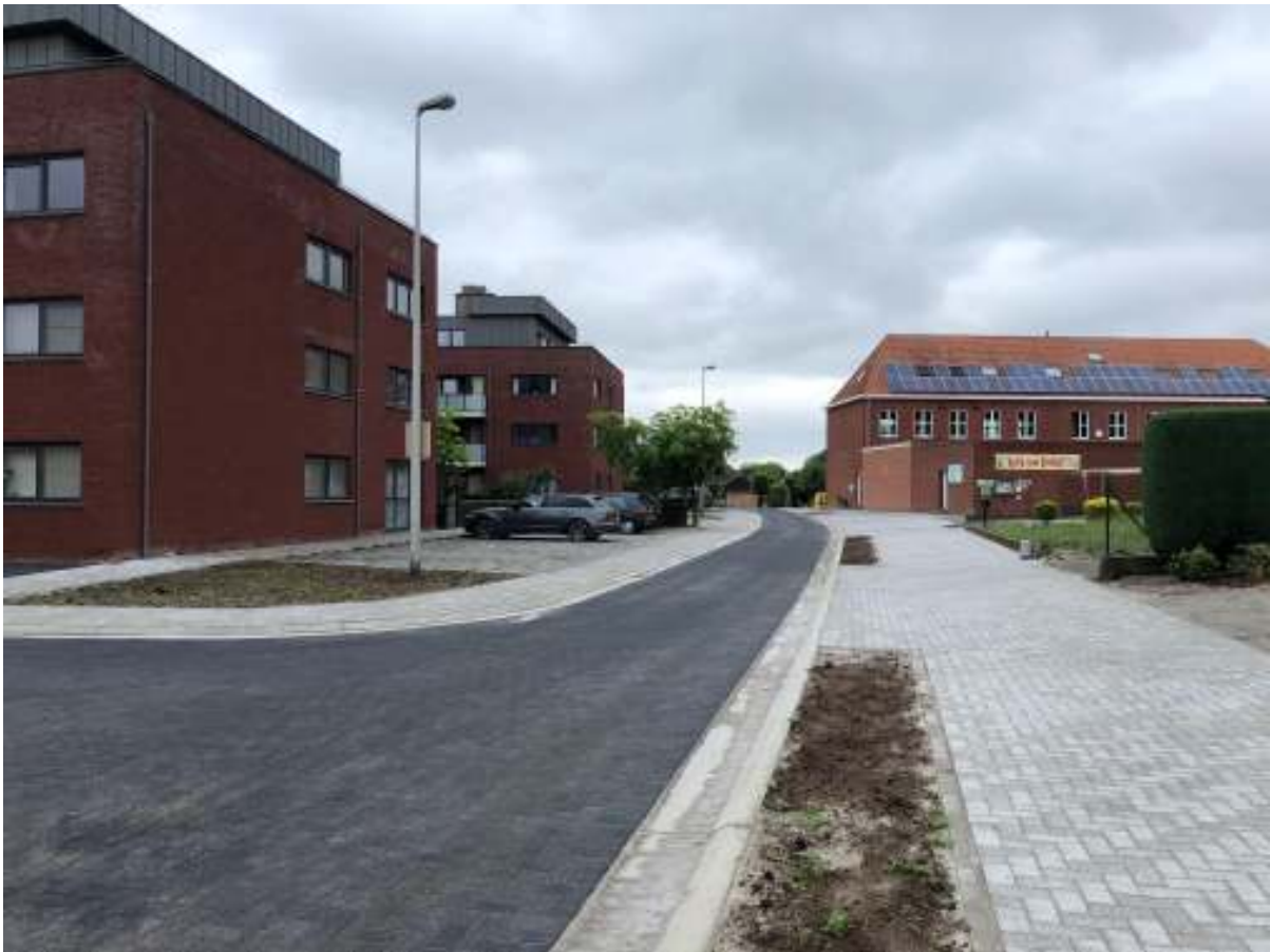
Ook de Schoolstraat mag gezien worden. Een deel ervan is voorzien van antracietkleurige betonstraatstenen.
