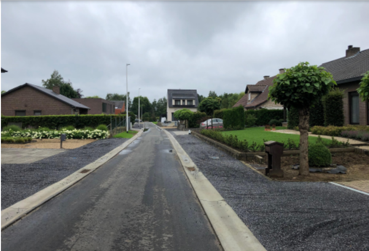
De Ruitersstraat zit zo goed als volledig in het nieuw. De toplaag asfalt volgt later.
